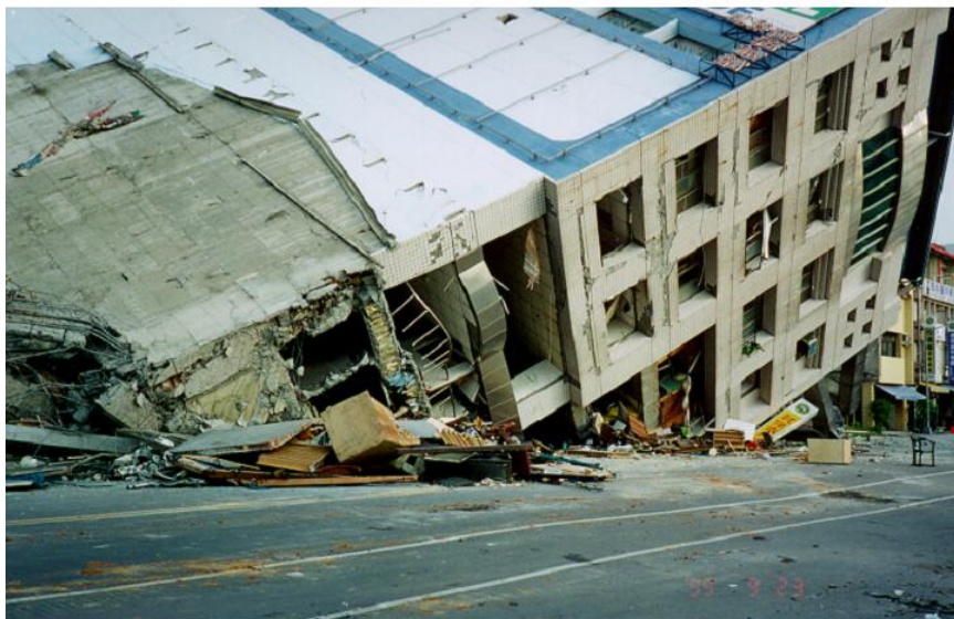
921 地震時台中霧峰中正大樓倒塌情形
