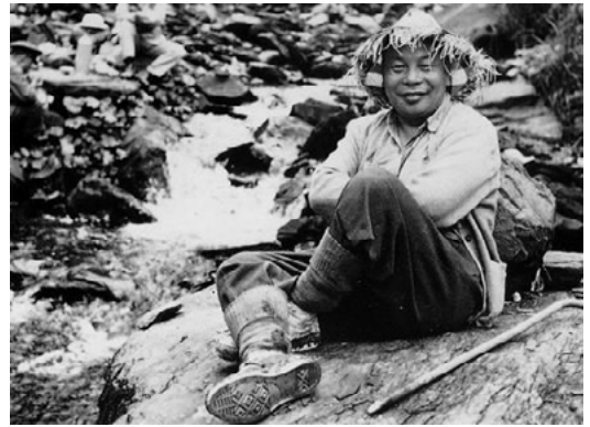
1950年代，头戴斗笠的蒋经国，巡视公路施工时的情形。
